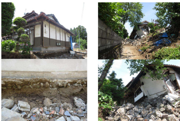
図 7 西原村布田地区の建物被害
